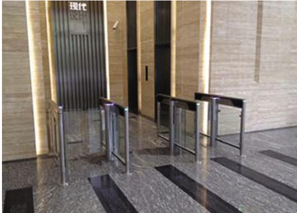
安装与上海现代集团大堂的安全门 SlimLane Gate
